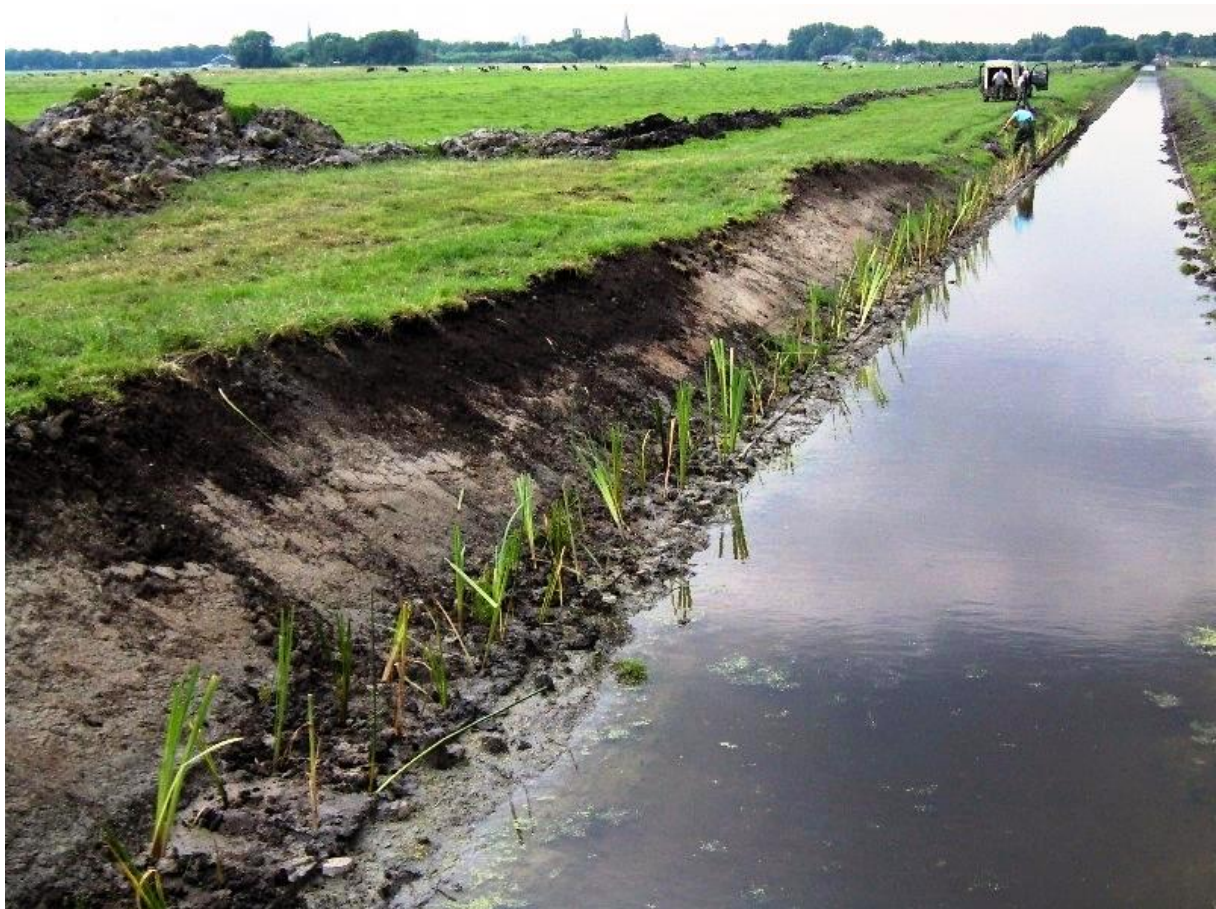
Aanleg en aanplant in de Commandeurspolder
